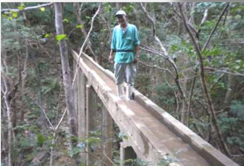
W-BRIDGE 研究活動で復活した 棚田水路橋(宇嘉地区)
